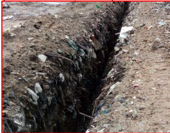
Figura 4. Escavação do aterro sanitário para instalação dos drenos horizontais de PEAD
