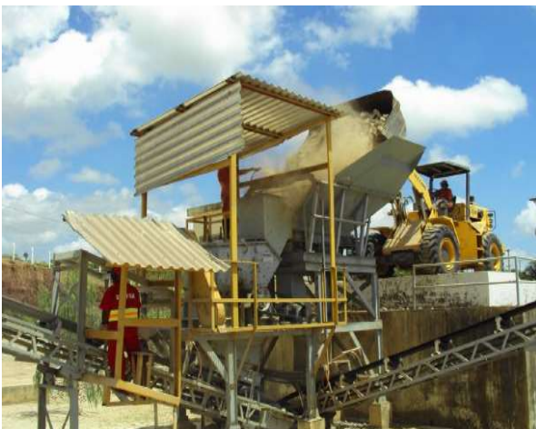
Figura 5. Britador de RCC
