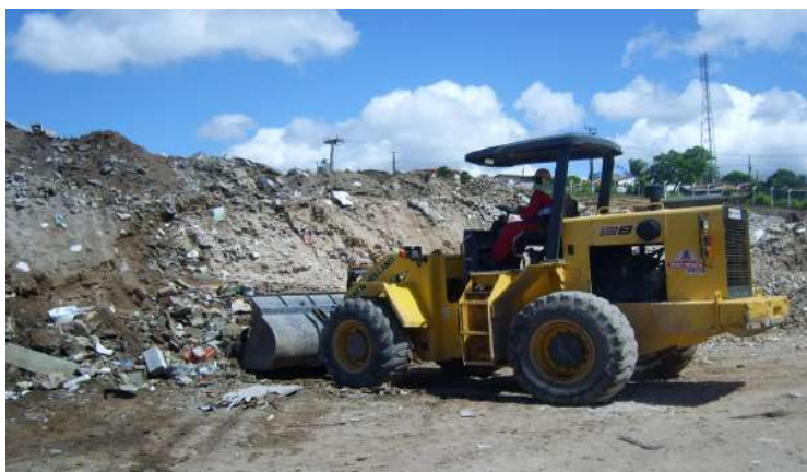
Figura 4. Área de estocagem e segregação do material
