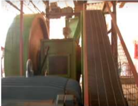
Figura 7. Briquetadeira da fábrica
