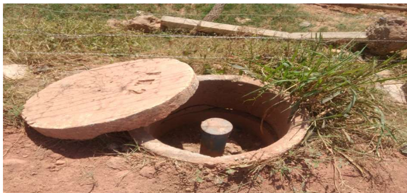
Figura 5. Poço de monitoramento número 2 do aterro controlado de Teresina
