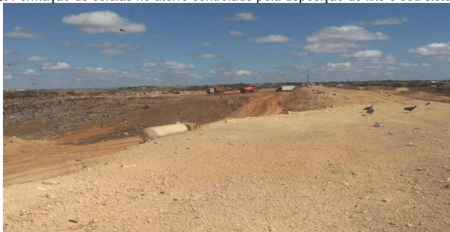
Figura 3. Formação de células no aterro controlado pela deposição do lixo e seu sistema viário
