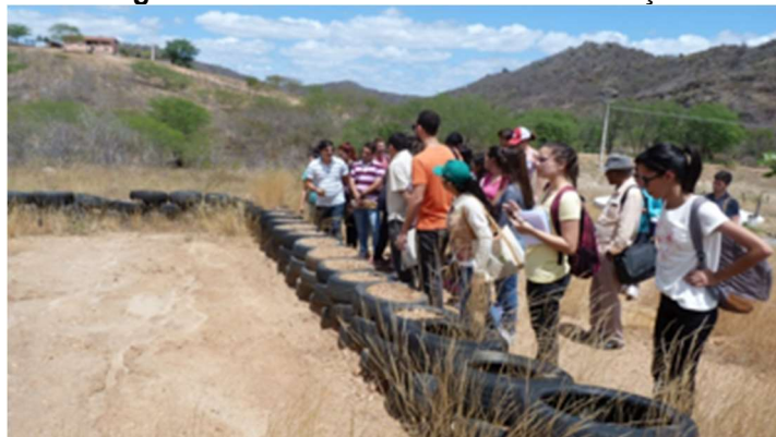
Figura 06. Visita de estudantes à construção
