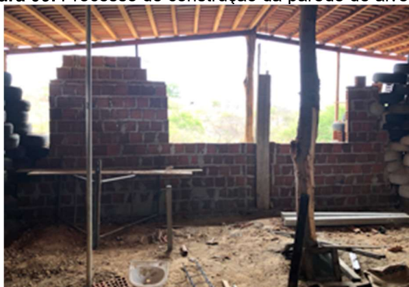
Figura 09. Processo de construção da parede de alvenaria
