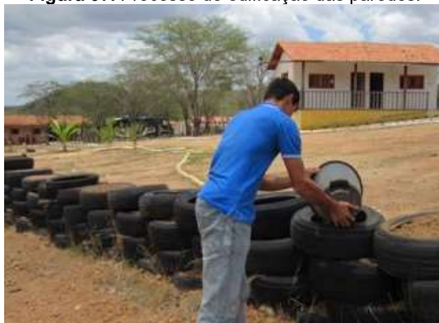
Figura 07. Processo de edificação das paredes.
