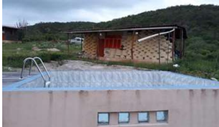
Figura 11. Destaque do sistema de coleta de água pluvial.
