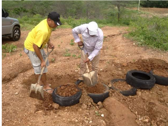
Figura 04. Momento inicial da construção
