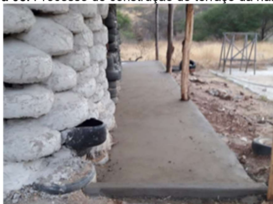
Figura 08. Processo de construção do terraço da habitação
