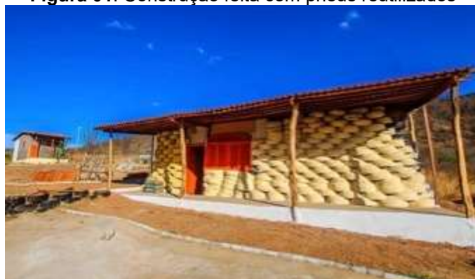
Figura 01. Construção feita com pneus reutilizados
