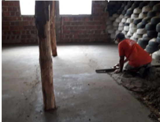
Figura 10. Processo de construção do piso interno
