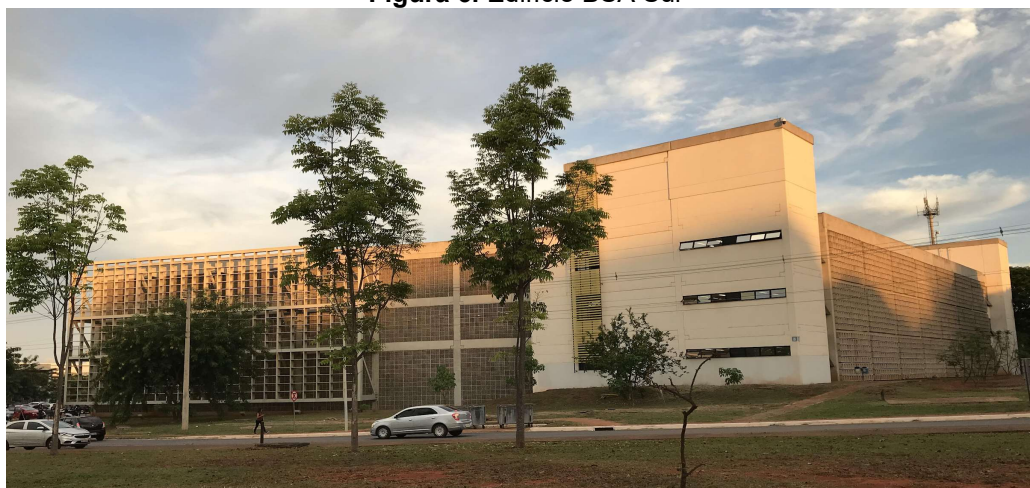
Figura 6. Edifício BSA Sul
