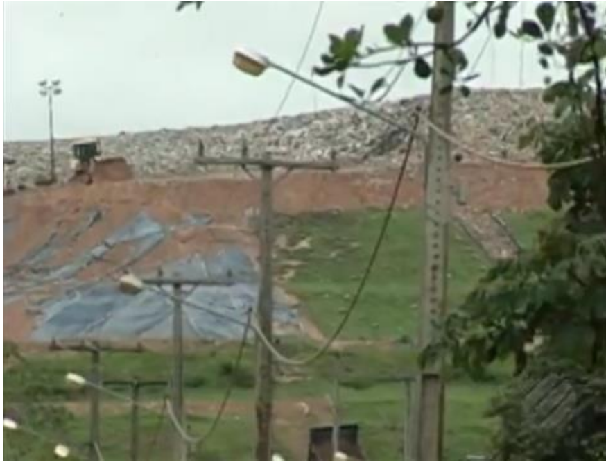
Figura 5: Imagem do sistema precário de proteção do aterro sanitário de Marituba/PA. Fonte: G1, 2017.
